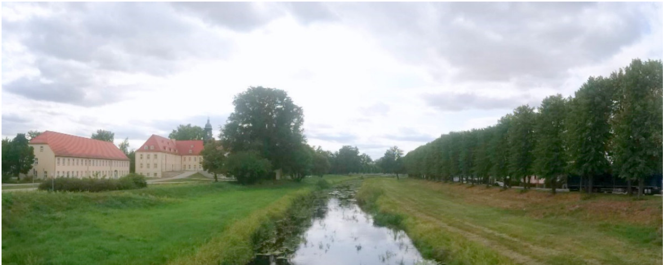
Foto 3 - Elsterdeiche zwischen Elsterschloss-Gymnasium und Straße B169 TO 1 [LfU, 2018]
